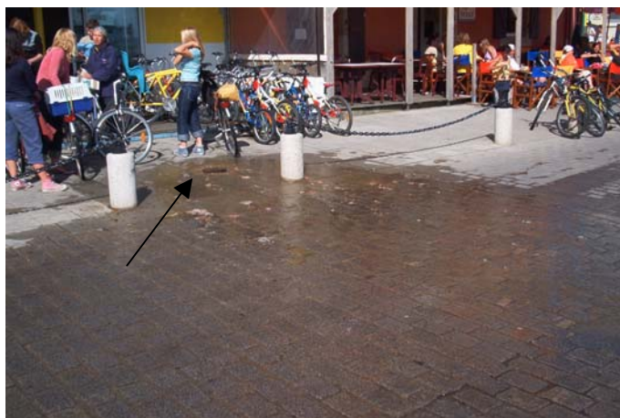
Figure 38. Débordement du réseau d'eaux usées à Port Tudy, le 21 août 2004.
