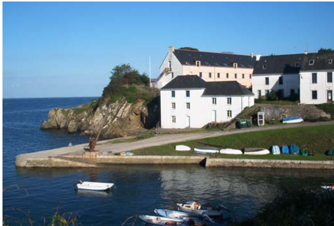
Figure 52. Projets de réhabilitation.
