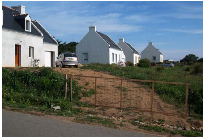
Figure 34. Constructions récentes sur la route de Port Mérite. Un effort est porté pour rappeler le style traditionnel mais la disposition des maisons dénotent avec l'habitat groupé traditionnel.
